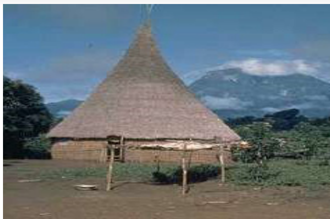
Figura 1. Vivienda tradicional Pemón (Tapüy) Fuente: Arquitectura tradicional (2018)
