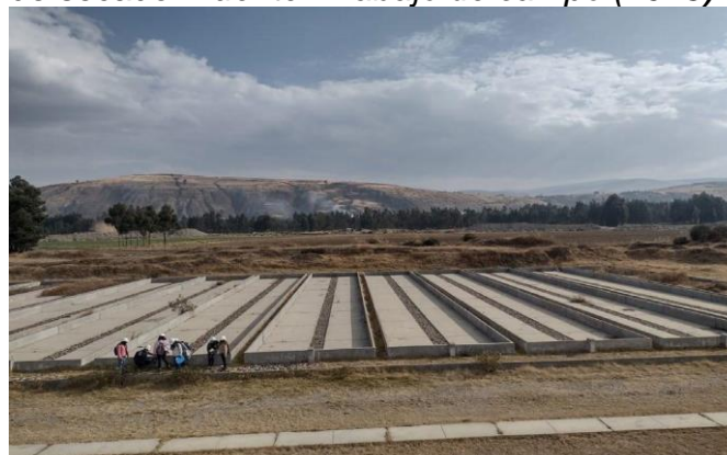
Figura 5. Lechos de secado. Fuente: Trabajo de campo (2023)
